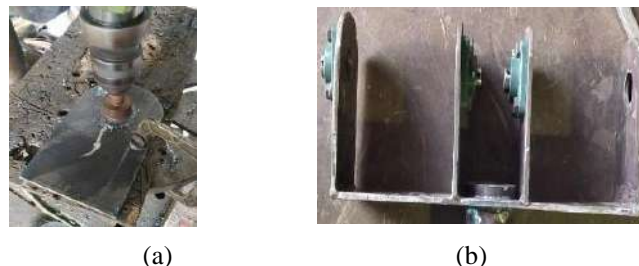
Gambar 6. rangka bagian tengah : (a) pelubangan (b) penyambungan dudukan solar tracking
