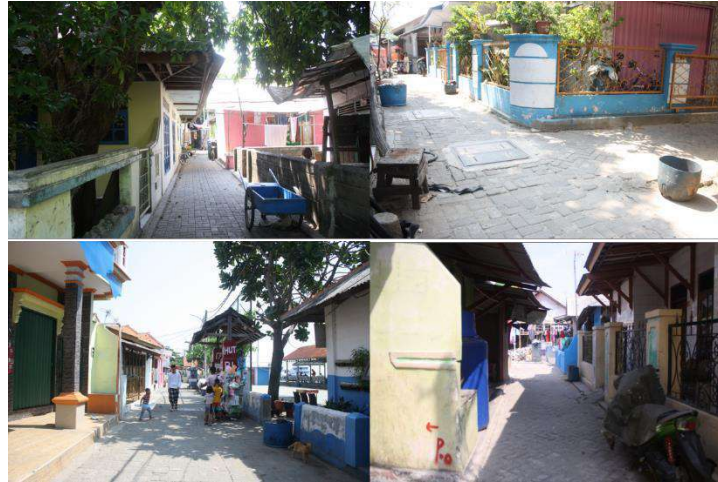
Gambar 1.a. Kondisi Jalan Utama di Pulau Panggang
