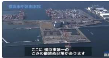
Gambar 13. Dermaga pabrik pembakaran sampah.
