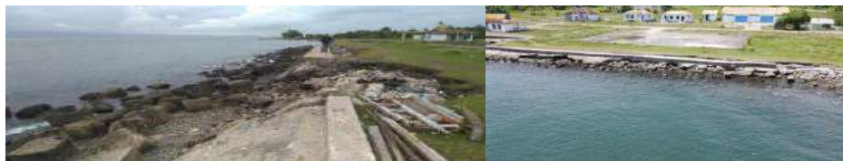
Gambar 4. Kerusakan Talud Sumber: Survei Lapangan (2023)
