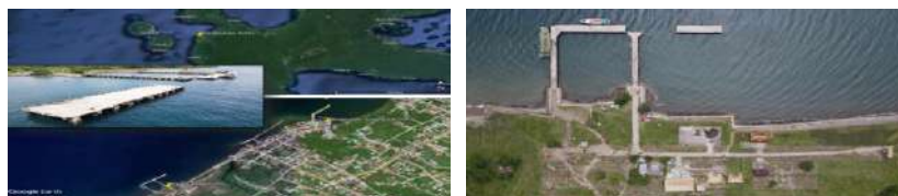
Gambar 1. Lokasi Pelabuhan Sofifi Sumber: Google Earth dan Dokumentasi Lapangan (2023)
